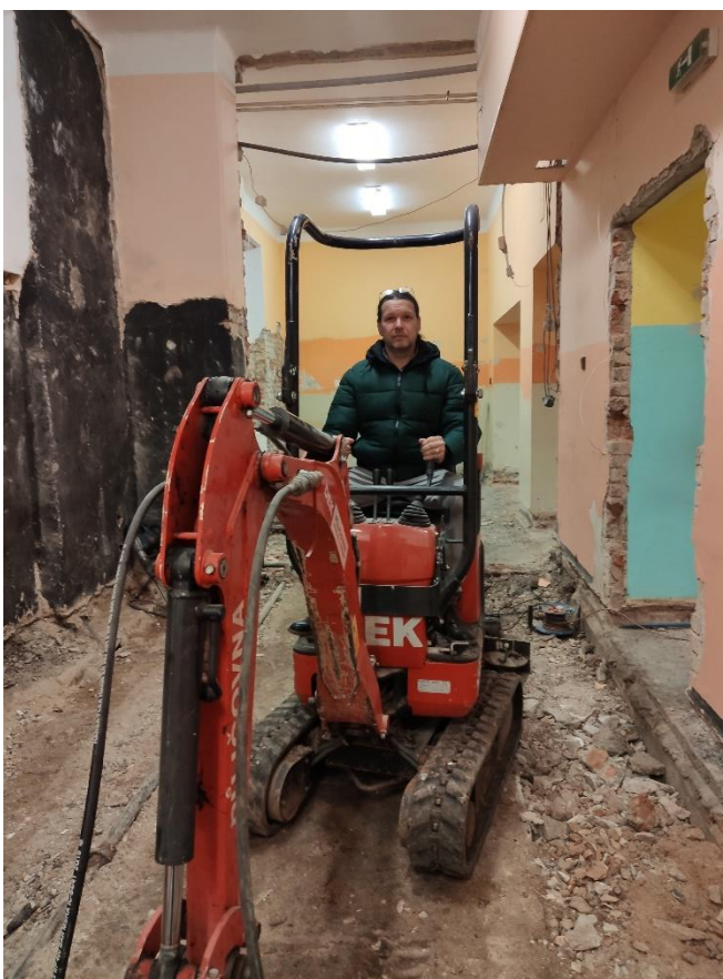
Obr. 5 – Hlavní kanalizace v budově
